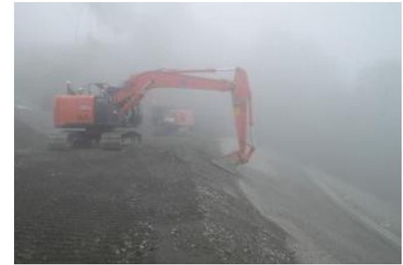
<濃霧条件下での施工>
