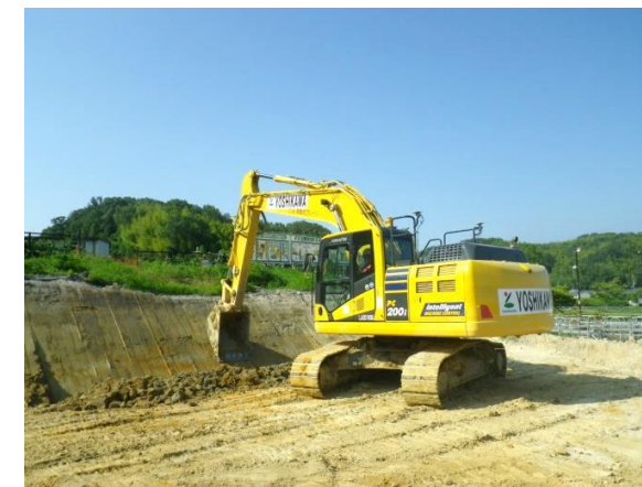
<ICT建機による施工>
