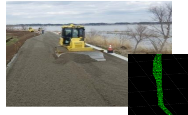
＜3次元設計データによる路盤敷均し＞
