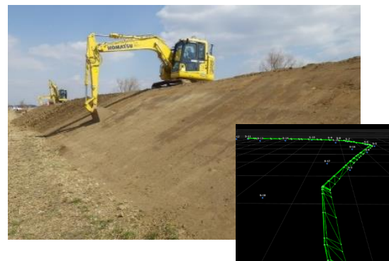
＜3次元設計データによるICT土工＞
