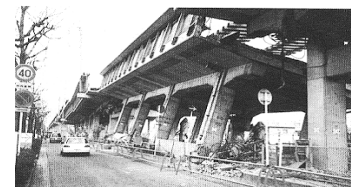
大規模地震により倒壊した高架橋 (阪神・淡路大震災)
