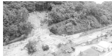
平成30年7月豪雨により崩壊した斜面 (JR呉線)
