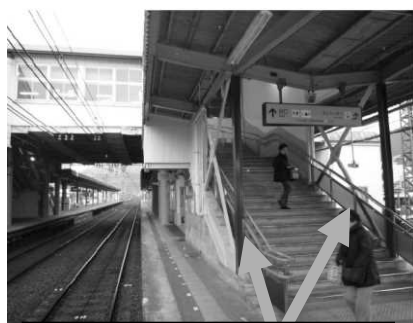
鉄骨ブレースによる補強
