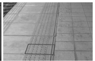
内方線付き点状ブロック
