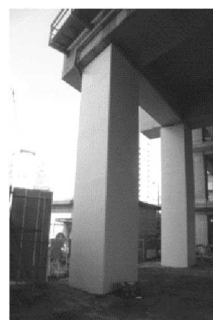
鋼板巻きによる高架橋の補強
