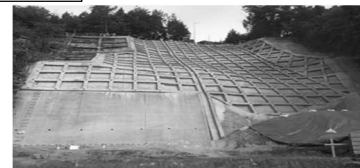
コンクリート枠による補強
