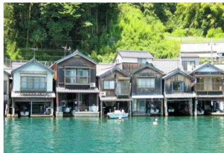
舟屋をカフェ・宿に改装して運営 (伊根 油屋の舟屋「雅」)
