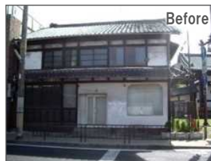
空き家の活用
