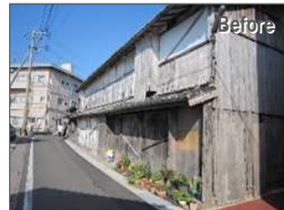
空き家の除却
