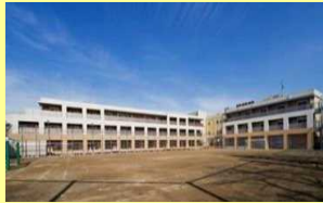
学校を改修して整備した事例
