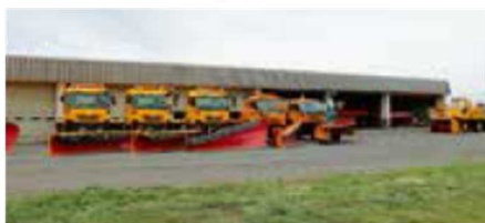
除雪機械格納庫
