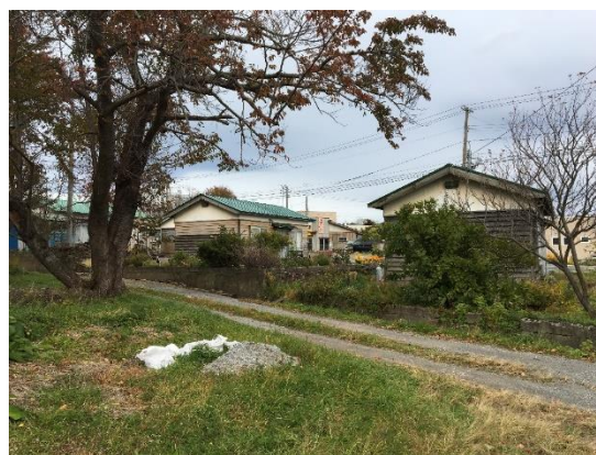
文京町団地現況写真
