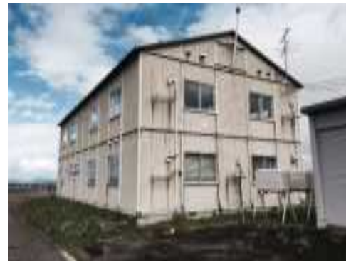
217:旧建設事務所
