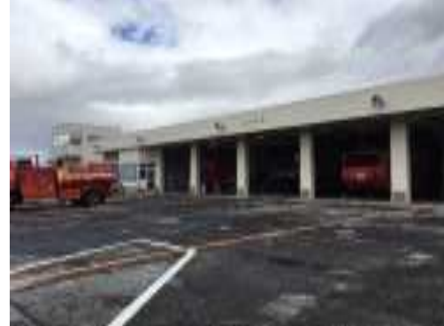
211:消防車庫(B棟)
