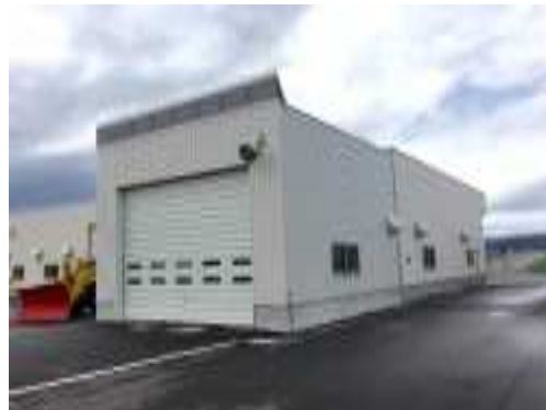
3131: 除雪車庫(増築分)
