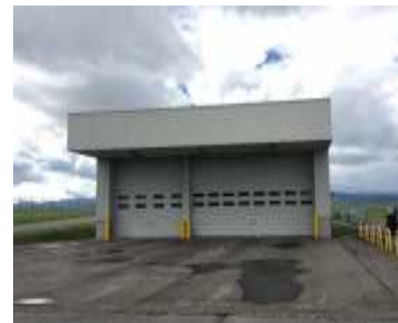
冬期機材格納庫 2
