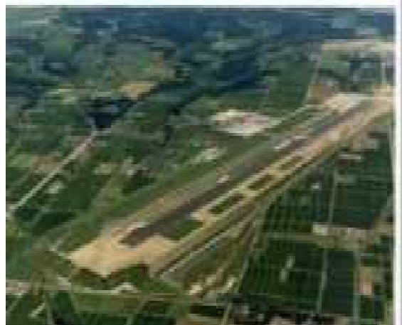
●滑走路 2,500m 工事② 滑走路の舗装工事
