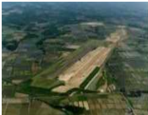
滑走路2,500m工事① 用地造成
