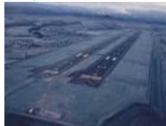
滑走路2,500m工事③ 供用時
