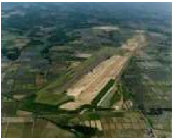
●滑走路 2,500m 工事① 用地造成
