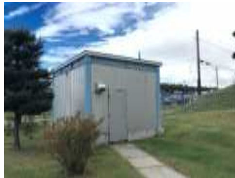
3164: レンタカー施設用受水槽上屋
