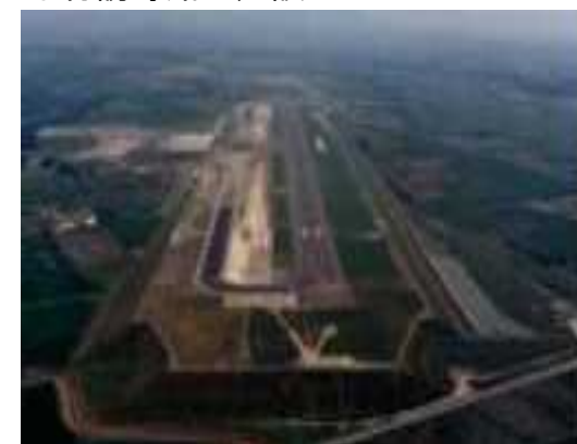
滑走路2,500m工事④ 平行誘導路の建設
