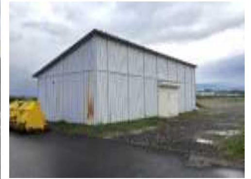
210:除雪車庫裏機材庫
