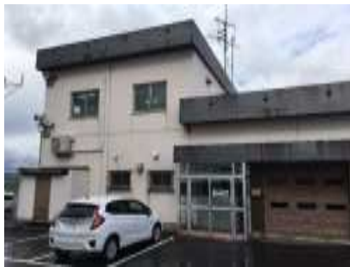
209: 空港管理事務所 (電源局舎 2F)
