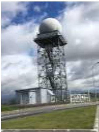
ASR (空港監視レーダー)
