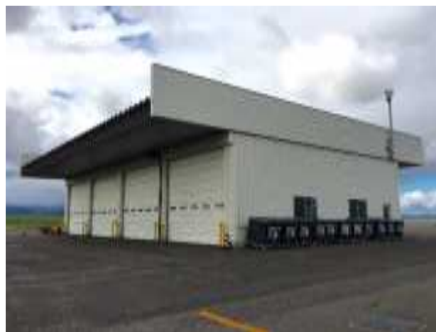
冬期機材格納庫 1
