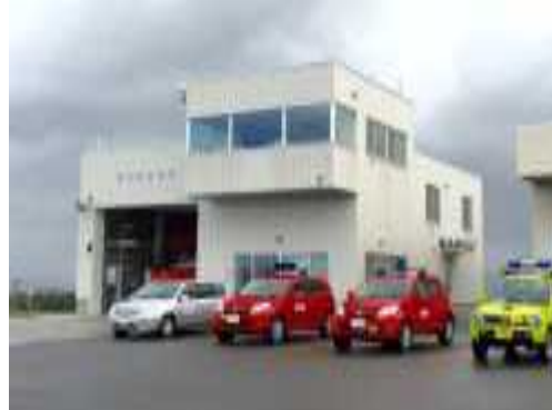
3130:消防車庫(A棟)
