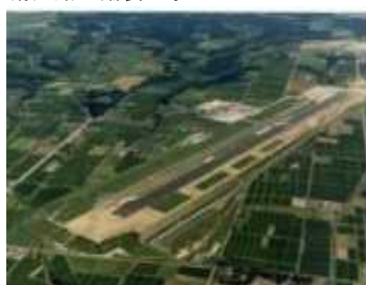
滑走路2,500m工事② 滑走路の舗装工事
