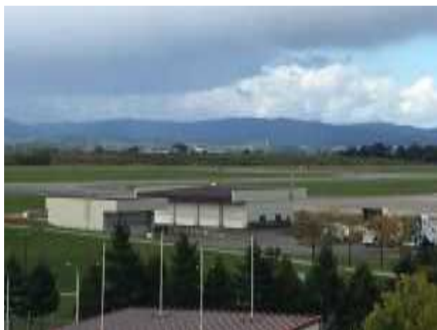
冬期機材格納庫全景
