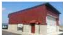
防災対策車庫
