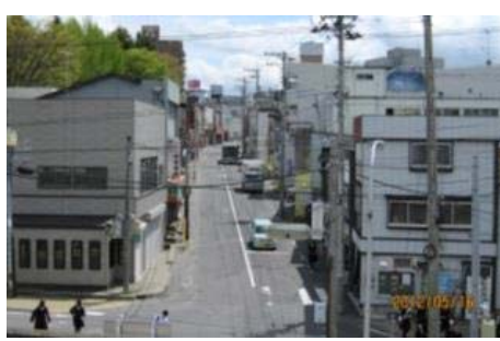
写真 1-4 本八戸駅通り
