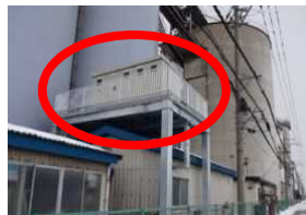
電気系設備の嵩上げ
