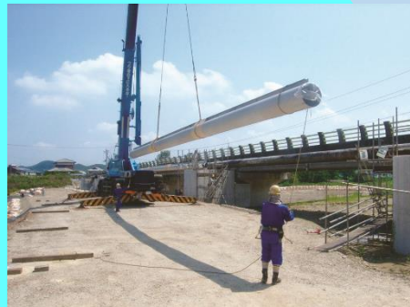
水管橋の耐震対策状況
