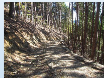
嶺北地域での作業道の開設状況
