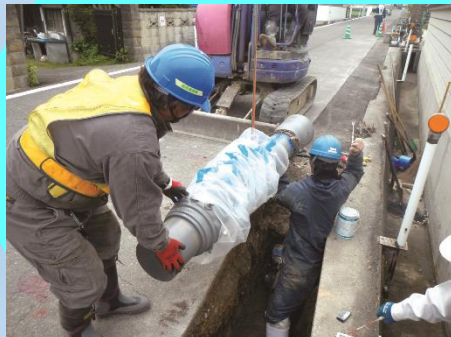
水道管の耐震対策状況
