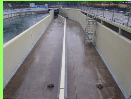
耐震対策施工後
