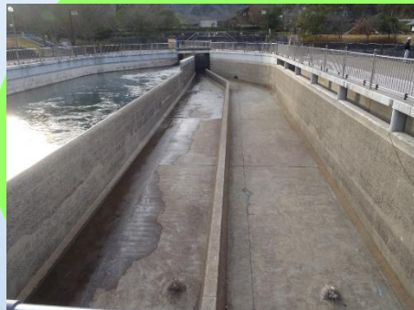
耐震対策施工前
