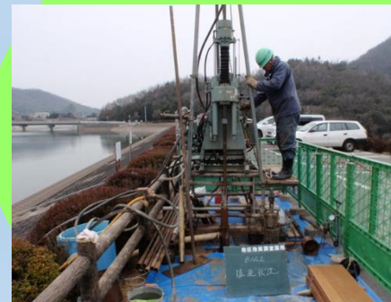
ため池の地質調査状況
