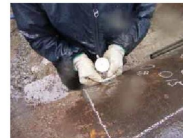
管体調査による老朽度判定
