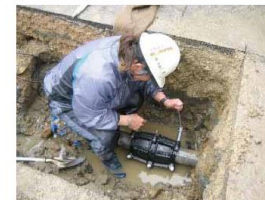
漏水箇所の修繕状況
