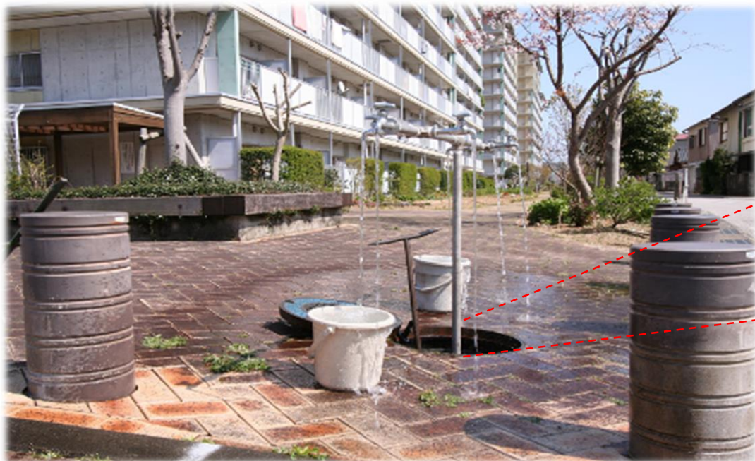
給水スタンド設置状況(北竹島町)
