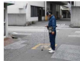
漏水調査状況
