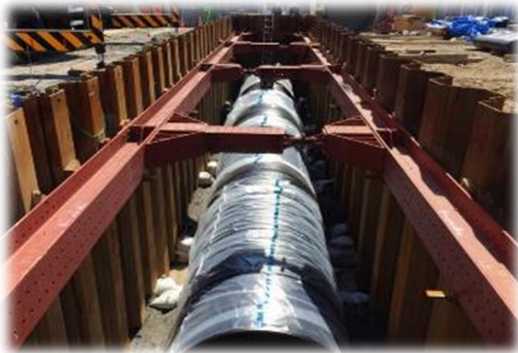
耐震性非常用貯水槽設置時の土留工
