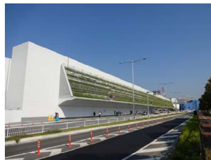
■旅客ビル外壁 (新1ビル)
