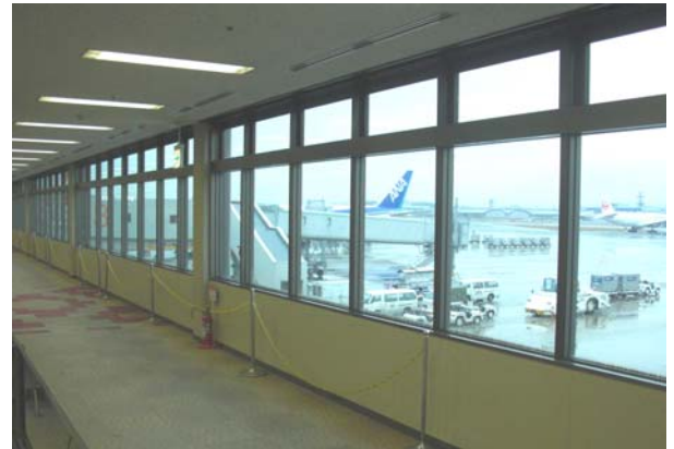
■窓ガラスへの断熱塗装
