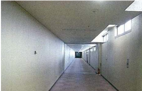
■人感センサーを利用した照明の自動点灯
