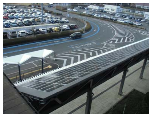
■ 太陽光発電パネルの設置
