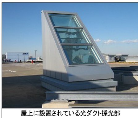
図-14 外光の有効利用（光ダクトシステム）
