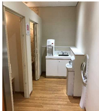
授乳ブースと給湯設備
