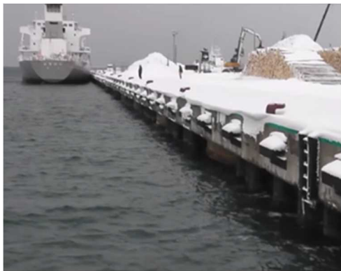
【内航油タンカー船 999吨】
