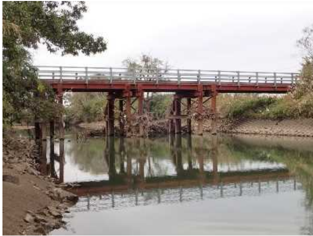
遠望目視(変状箇所の確認は困難)
