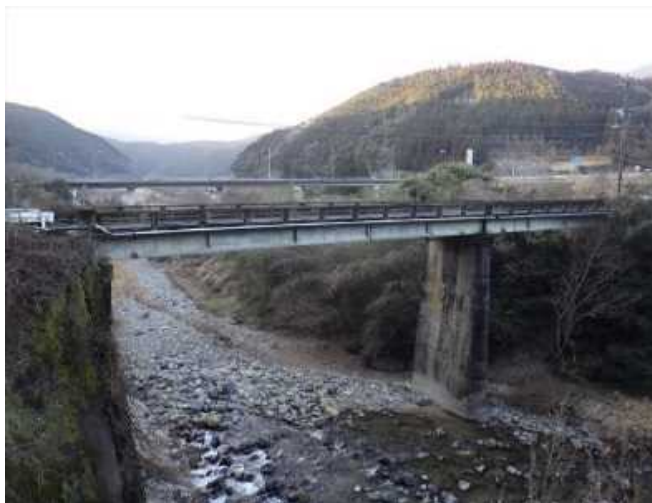
遠望目視(変状箇所の確認は困難)
