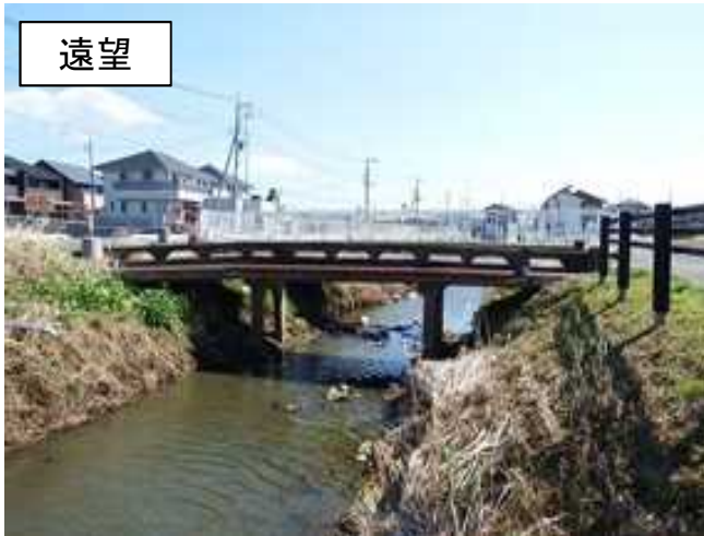
遠望目視(変状箇所の確認は困難)
