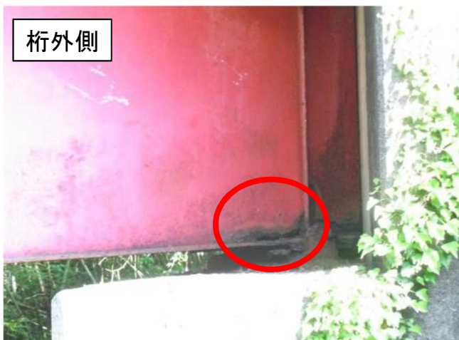
桁外側からの近接目視の状況 (変状の確認は困難)
