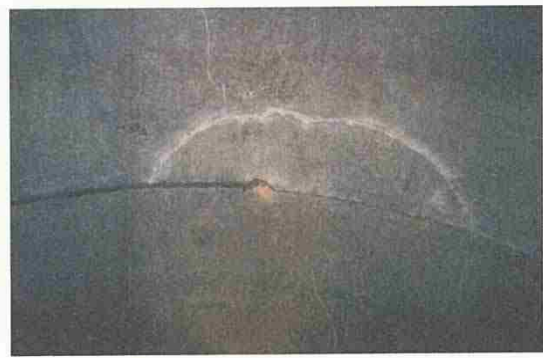
付写真-1.1.1 横断方向目地の天端付近に発生した半月状のひび割れの例
