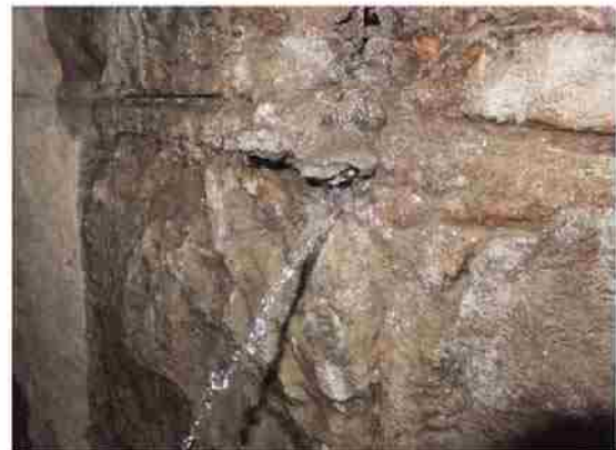
付写真-1.4.3 漏水（噴出）している例
