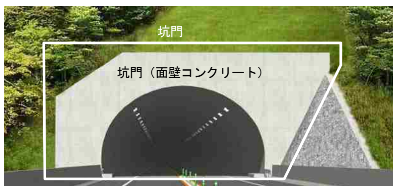
別図-1.2 点検対象箇所（トンネル坑口部）
