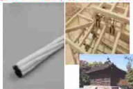
善光寺経蔵の耐震補強へ採用
