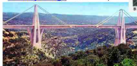
Wadi el Kuf Bridge, Libya
