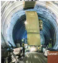
〈トンネル覆工〉
