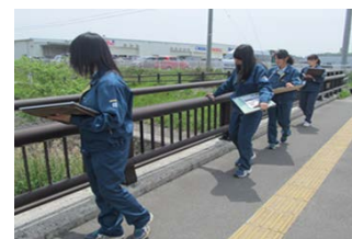
高校生による橋梁の日常点検 (橋のセルフメンテナンスふくしまモデル)
