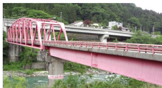
<音沢橋の状況>
