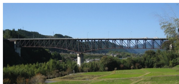
<乙姫大橋の状況>
