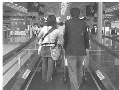
写真7 ゆったりとした幅の傾斜型動く歩道
