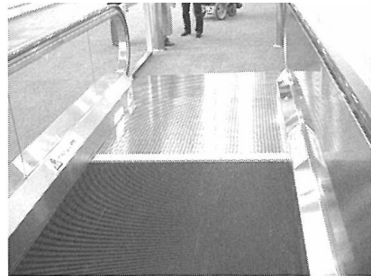
写真5 ゴムベルト式の動く歩道の場合は、コムの厚さを薄くすることができ、コム部分の段差はほぼ解消された (2005年1月、開港前の確認作業時)
