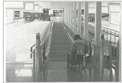
写真2 アクセスマラザとターミナルビルの連絡路の傾斜型動く歩道。パレット式の動く歩道が1/15の勾配のある連絡路に併設された。歩道面には動きがわかるように部分的に着色が施されている (2005年1月、開港前の確認作業時の撮影)
