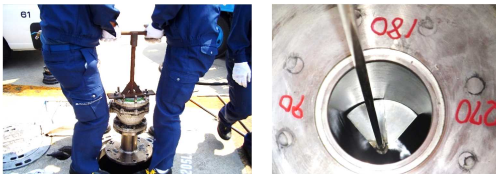
図 2-2 ハイドラント配管健全性確認作業状況
