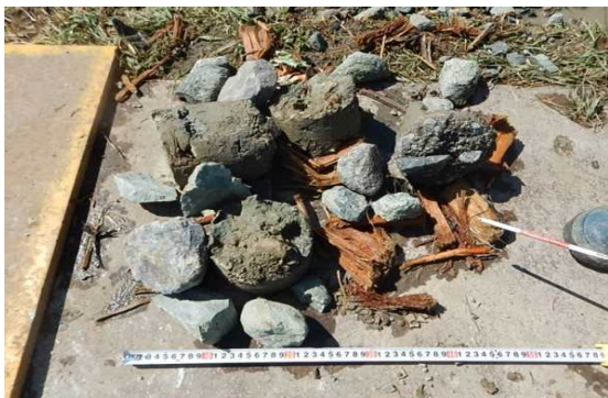
写真-4 地中障害物の状況写真
