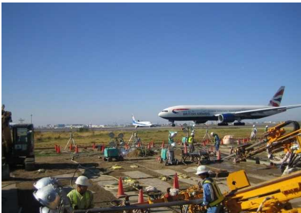
写真-1 曲り削孔施工写真
