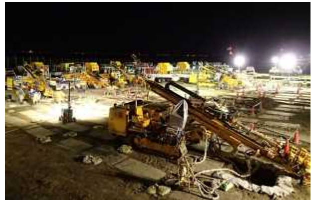
写真-2 曲り削孔機
