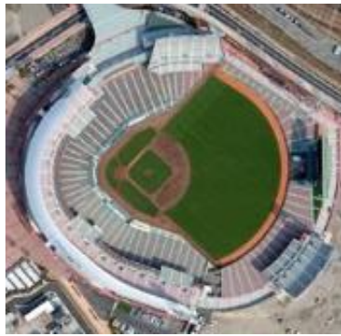
大州雨水貯留池 上部利用
