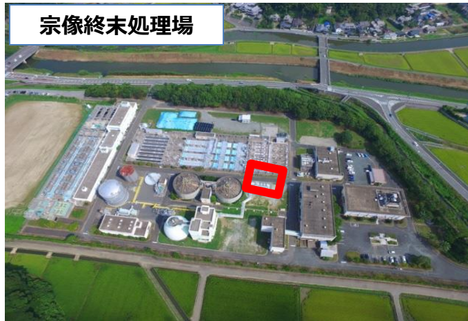
消化ガス発電設備
