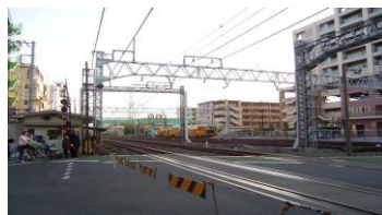
踏切障害事故 《死者2名、負傷者2名》
