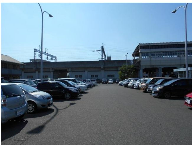
⑦第2駐車場西側方向
