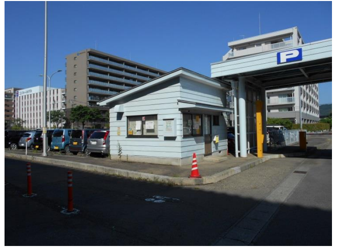
④管理棟（現在は物置）
