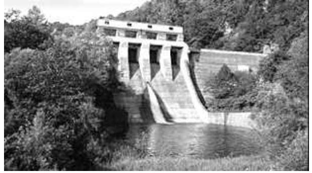
かさ上げ予定の雨竜第2ダム
