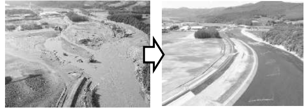
【事例】石狩川水系空知川の復旧状況
