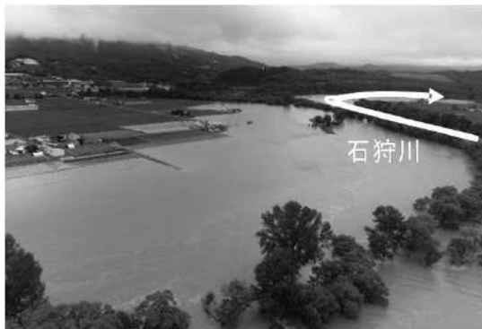
石狩川の浸水状況（深川市納内）
