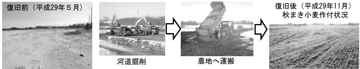
【事例】十勝川水系戸蔭別川の掘削土砂を利用した農地の復旧
