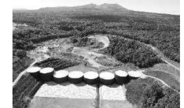
樽前山覚生川2号砂防堰堤（苫小牧市）
