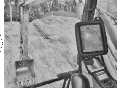
ICT建設機械による施工
