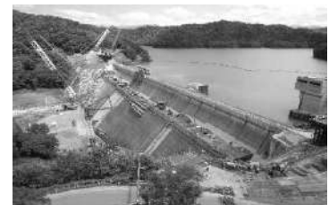
工事中の新桂沢ダム（三笠市）
