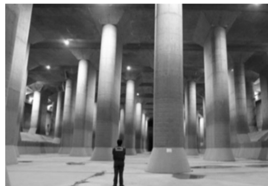
“地下神殿”と称される調圧水槽 (首都圏外郭放水路)
