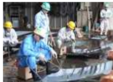
ぎょう鉄(鉄板曲げ加工)
