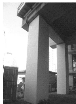
鋼板巻きによる高架橋の補強
