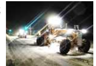
< 早めの通行止めによる集中除雪 >
