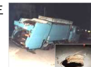
下水道の老朽化による道路陥没
