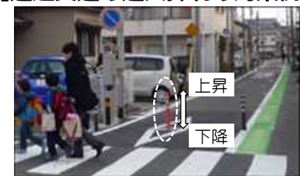
ライジングボラード <自動昇降する車止めで通過交通の進入を抑制>
