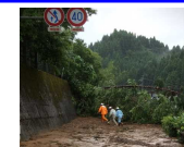
災害により通行できなくなった道路
