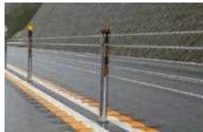
<ワイヤロープの設置事例>
