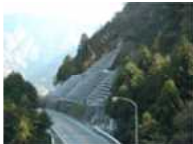
<のり面防災対策>
