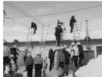
雪下ろし実技講習
