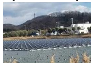
遊水池・ため池を活用し環境に配慮した水上太陽光発電（岡山県笠岡市）事例② （自然エネルギー財団HPより）
