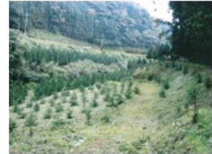
農地としての基盤整備、 農地の林地化などの実施 （大分県臼杵市）事例 ⑧ （中ノ川集落より提供）
