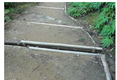
間伐材の古道排水溝への有効利用
