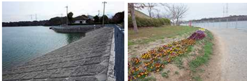
改修した副堤防（平成30年3月撮影）
