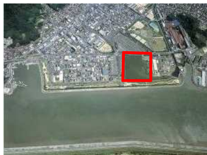
発電所を建設する以前の「十一番町遊水池」(グーグルアース画像を加工)
