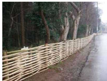
伐採した竹により作成したフェンス (里なびホームページより)
