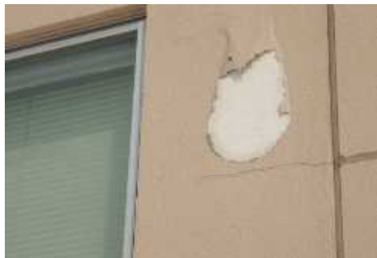
外壁のひび割れ、外装材の剥離及び膨れが見られる
