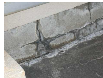
屋上躯体のひび割れ、鉄筋爆裂による発錆、ひび割れ、仕上の劣化が見られる
