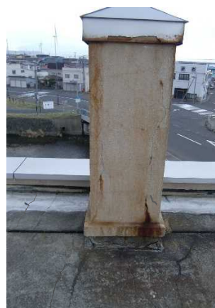
屋上躯体のひび割れ、鉄筋爆裂による発錆、ひび割れ、仕上の劣化が見られる
