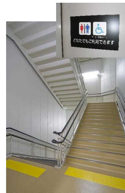
階段への2段手すりの 設置や注意喚起表示
