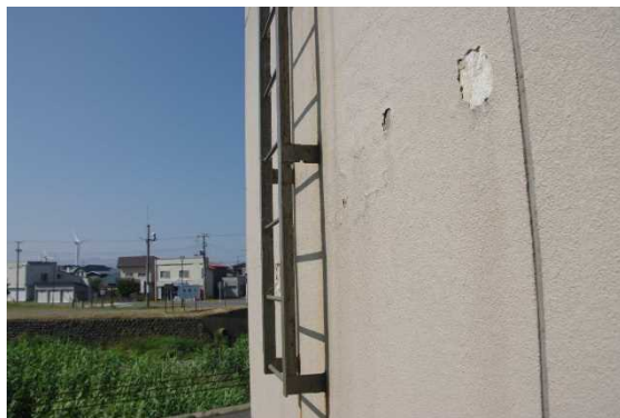
外壁のひび割れ、外装材の剥離及び膨れが見られる
