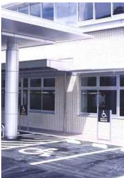
車いす利用者用 駐車場の整備
