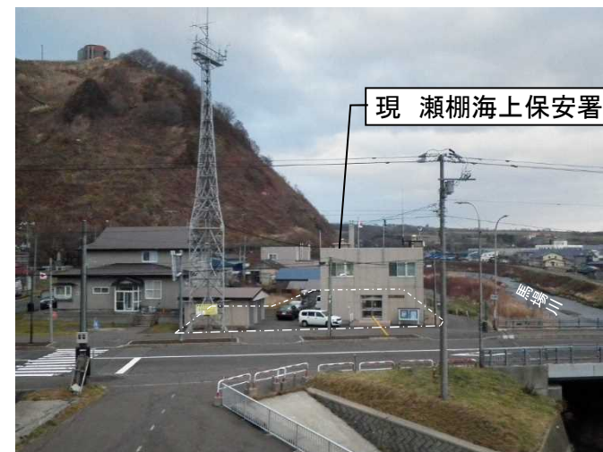
既存庁舎外観
