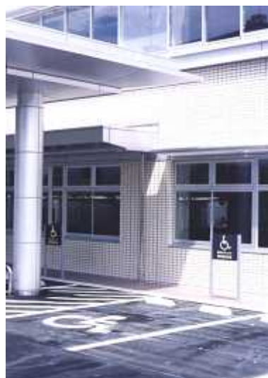
車いす利用者用 駐車場の整備
