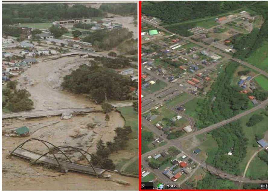
9月1日掲載北海道新聞と被害前の写真比較 ペケレベツ川石山橋
