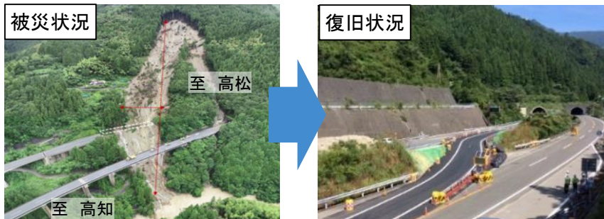
＜高知道(新宮～大豊)の被災事例(H30西日本豪雨)＞
