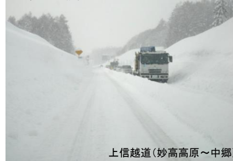
大雪による狭隘な道路空間
