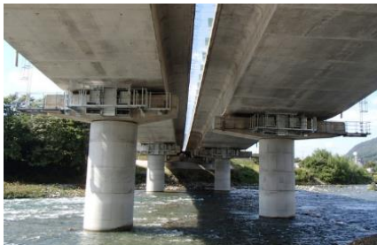
<対策例1:橋脚全体の補強>
