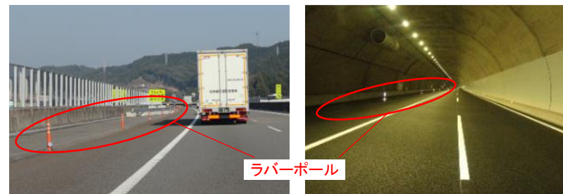
現況写真(構造物6車線対応区間)
