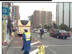
② 交通誘導員の配置
