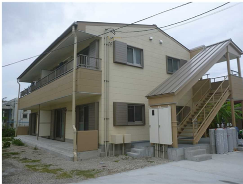
船員厚生施設(世帯用1棟4世帯)の整備
