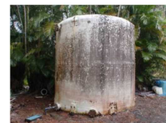
昭和47年に設置され、経年劣化が進み漏水が発生
