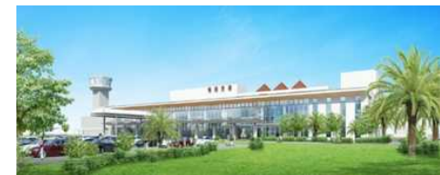
奄美空港ターミナルビル
