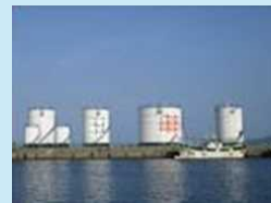
・離島の油槽所
