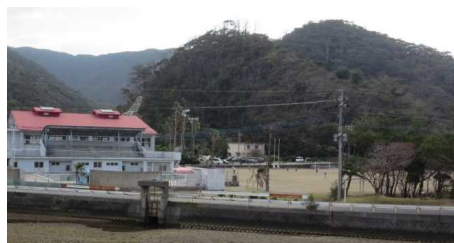
施工前(平成26年度)
