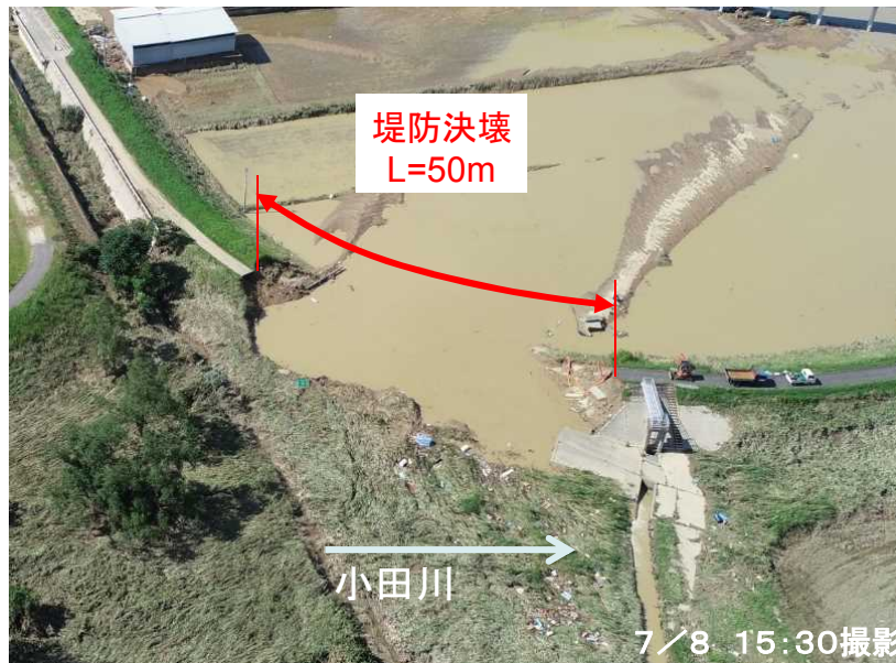
緊急復旧作業状況 【被災直後】
