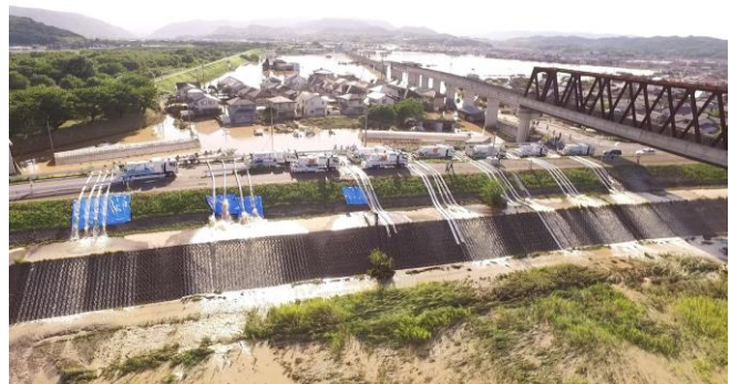
緊急排水作業（H30.7.8倉敷市真備町）
