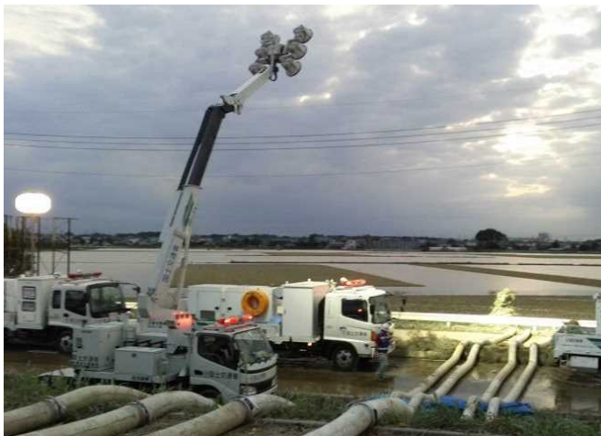
排水ポンプ車による排水作業
