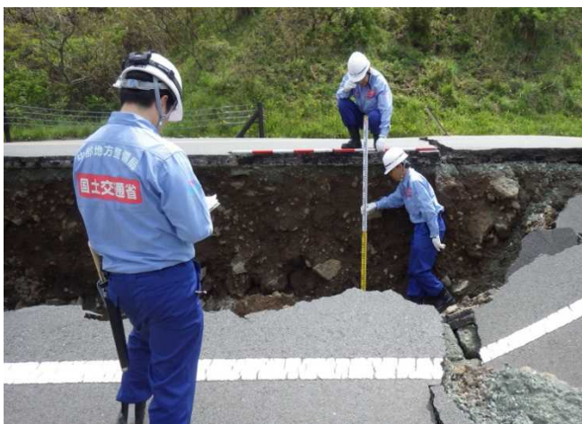
被災状況の調査
