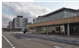
YKKが整備しているパッシブタウン
