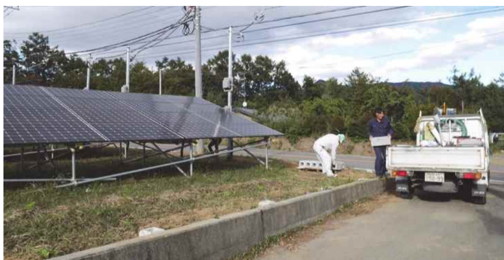
図4-4. フェンスと植栽の工事が行われている事例 (2017年10月4日撮影)
