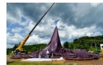
設置中の様子
